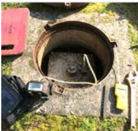
Dispositifs de surveillance de l'aléa émission de grisou, mesures périodiques manuelles, source : BRGM
