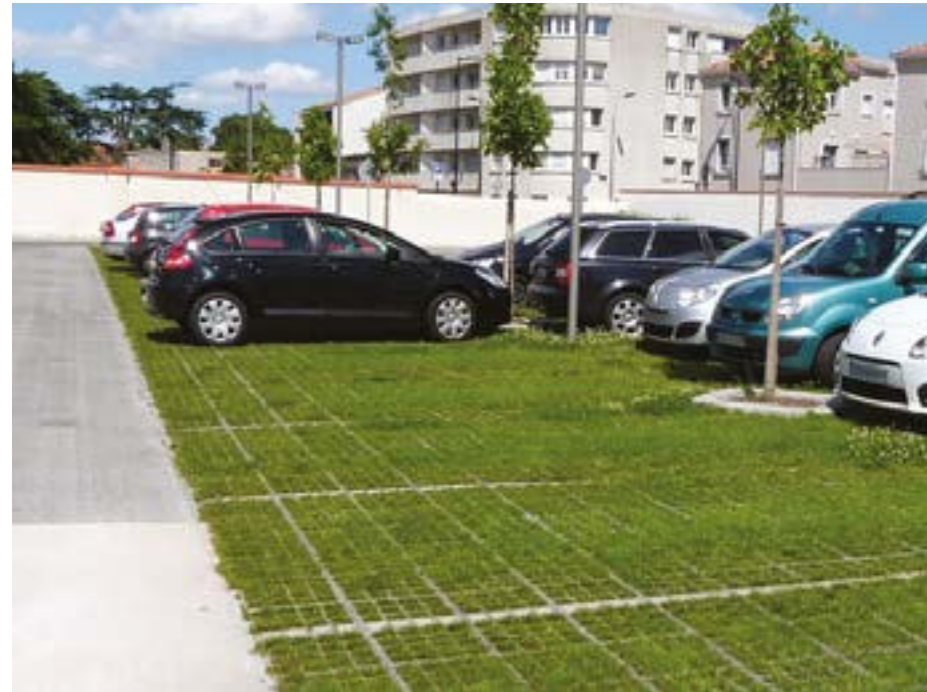
Parking végétalisé ©O2D ENVIRONNEMENT
