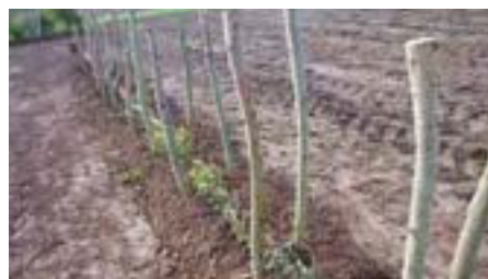
Construction d'une fascine © Agence de l'eau Artois Picardie - Chambres d'Agriculture des Hauts-de-France - SOMEA
