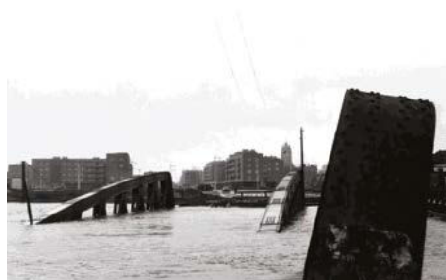
Pont de Rosendaël à Dunkerque ; Source : archives municipales de Dunkerque
