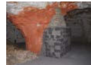
Confortement d'un pilier par maçonnerie (Lille) © INERIS
