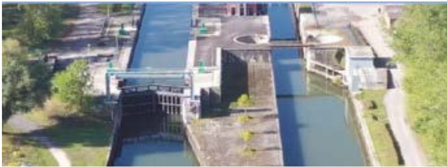
L'écluse de Denain après les travaux de 2021 © VNF - INGEO
