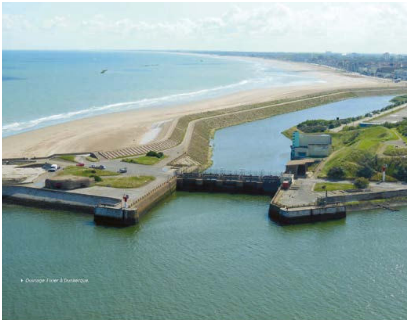
Ouvrage Tixier à Dunkerque - Crédits : Institution des Wateringues
