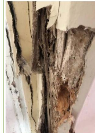
Nous constatons malheureusement depuis plusieurs mois une aggravation des désordres côté gauche de l'Arc magistral. Après inspection de l'état sanitaire du voûtement, nous constatons la présence de la mэрule. Il en résulte un fort risque d'effondrement qui a pour conséquence une interdiction de réouverture de l'édifice. Une estimation des travaux est en cours de réalisation par l'architecte.
